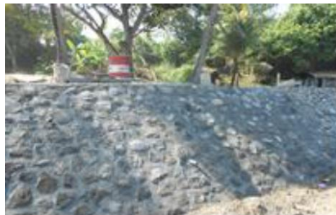
Gambar 6. Pemasangan Revetment dari Pasangan Batu Kali di Pantai Kedungu
