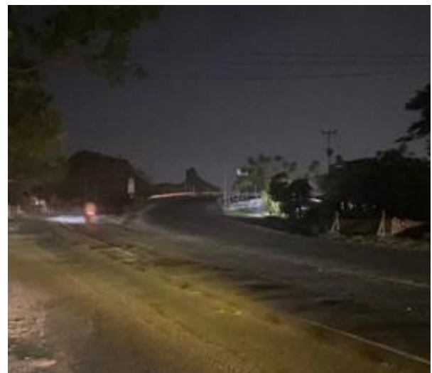
Gambar 8. Foto kondisi penerangan jalan
