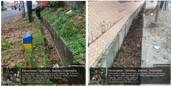
Gambar 3. Kondisi ekisting Drainase
