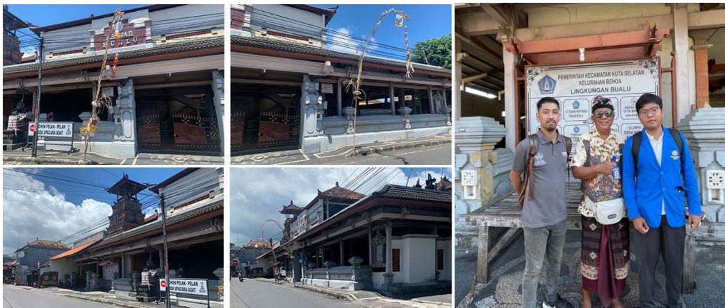
Gambar 1. Kondisi Eksisting Bale Banjar Bualu
