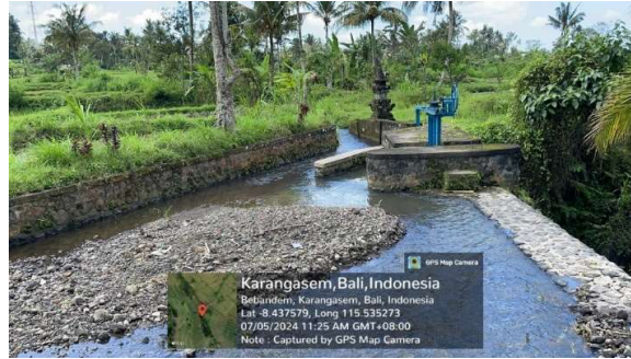
Gambar 2. Survey pada bangunan utama
